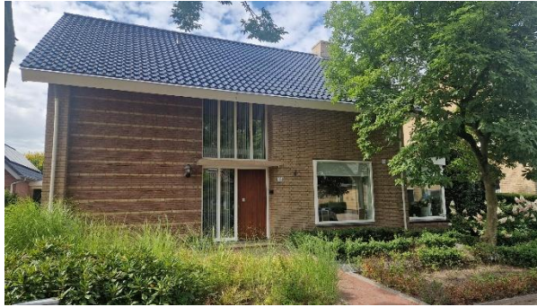
Hakschaer na de renovatie
